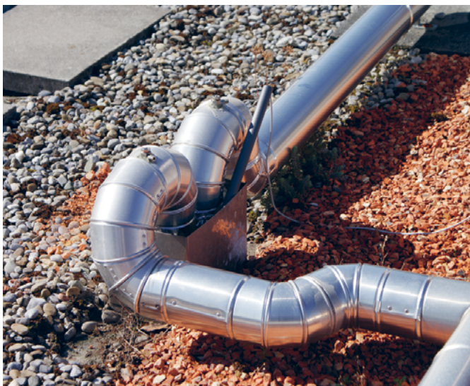
Impianto eliotermico: Disposizione dei collegamenti, passaggio attraverso la copertura aperto (a sinistra), con chiusura (a destra)
