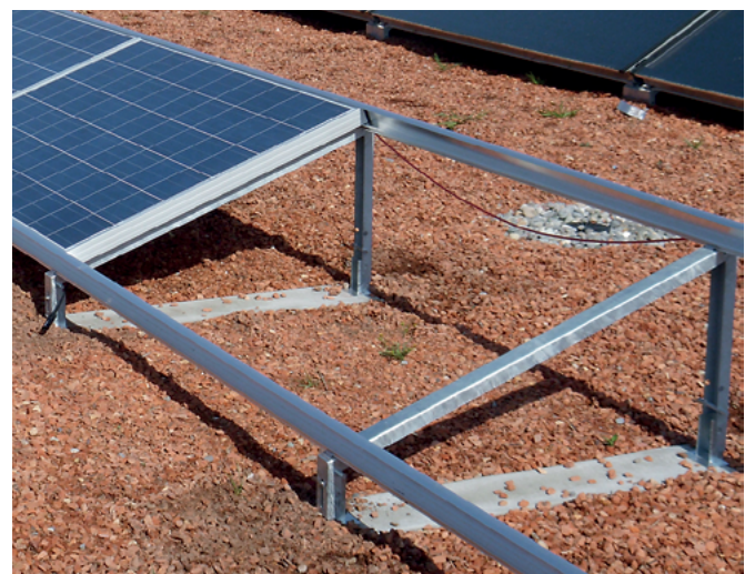
Montaggio del rialzo per tetti piani su una piastra di distribuzione della pressione (base in cemento)
