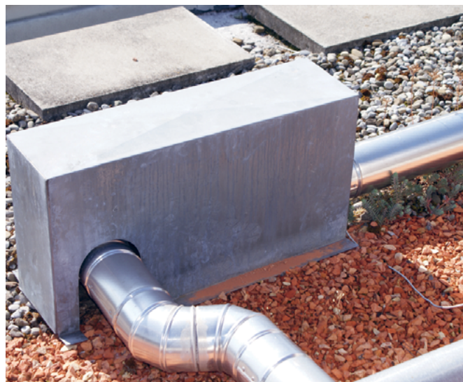
Impianto eliotermico: Disposizione dei collegamenti, passaggio attraverso la copertura aperto (a sinistra), con chiusura (a destra)
